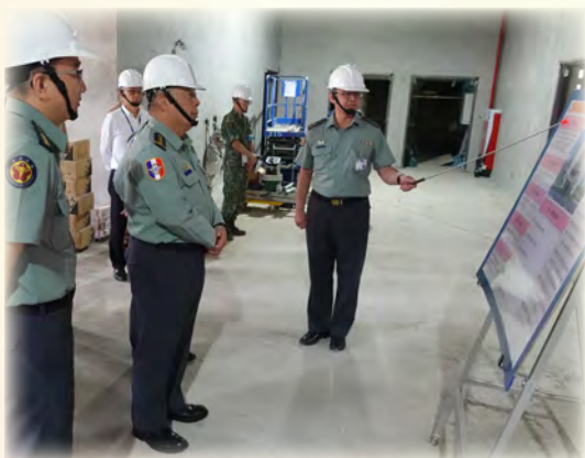
▲徐副部長視導大樓施工情形
