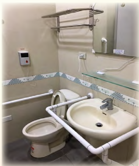
▲廁所裝設扶手
